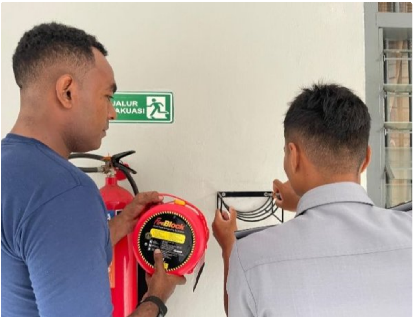
Antisipasi Kebakaran, Lapas Besi Tambah Pemasangan Fireblock
